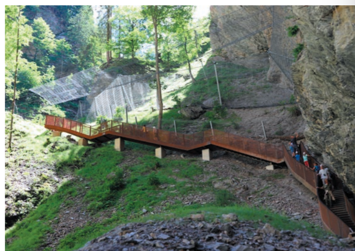
↑ Abb. 2: Treppen- und Schutzanlage in der Liechtensteinklamm Foto: Atelier Oczlon
